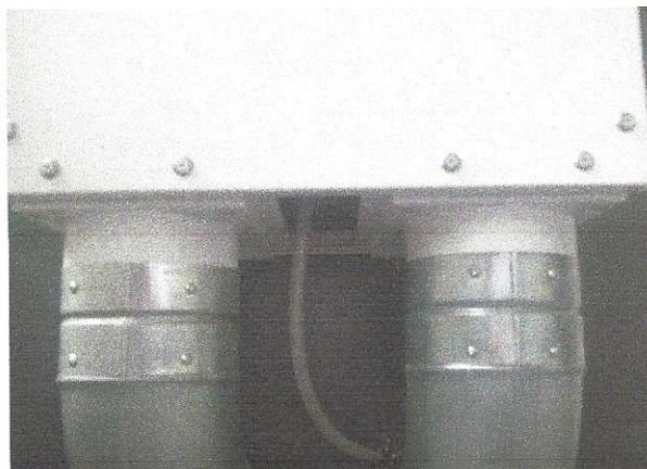
*Am Kondensatabfluss Ø 20mm mittels Schlauchbride den Siphon anschliessen.*
